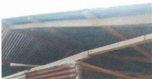
Foto 1: Vista panorámica cubierta con soporte de madera.
